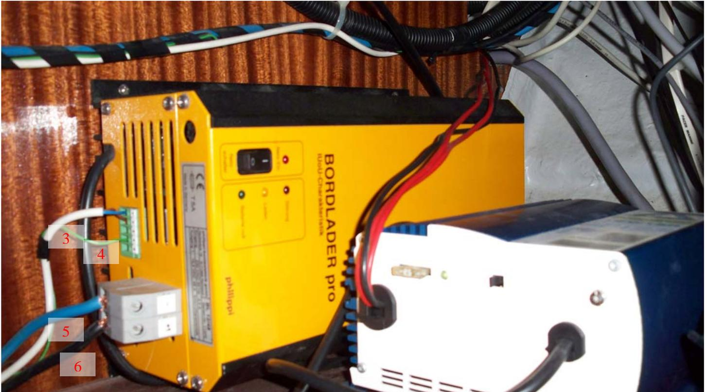
Le câble 3 deux fils est relié à une sonde de température qui se trouve dans le coffre à batteries. Le fil vert 4 est relié à la carte bavaria contrôle de charge. Les câbles bleu et noire sont les câbles de charge.
